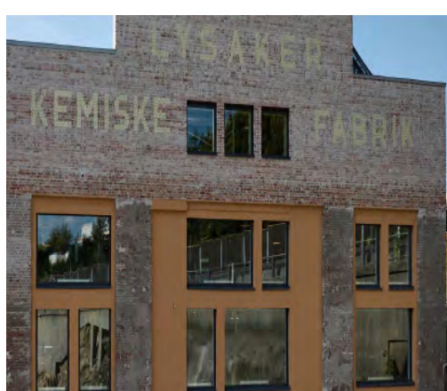
Lysaker Kjemiske Fabrikk Teglfasade
