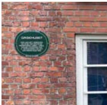
Skilt som beskriver byggets tidligere bruk.
