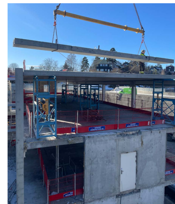
↑ Demontering av hulldekker for ombruk i Vollsveien 11.
