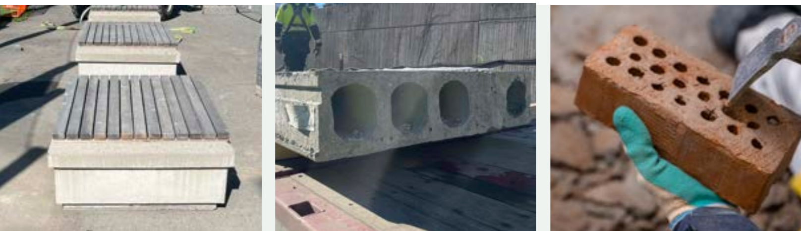
↗ ↑ Gamle flaggstang-fundamenter fra Lilleakerbyen har blitt til tribune/benk på nye Hovseter skole. Hulldekker og teglstein klargjøres for ombruk.
