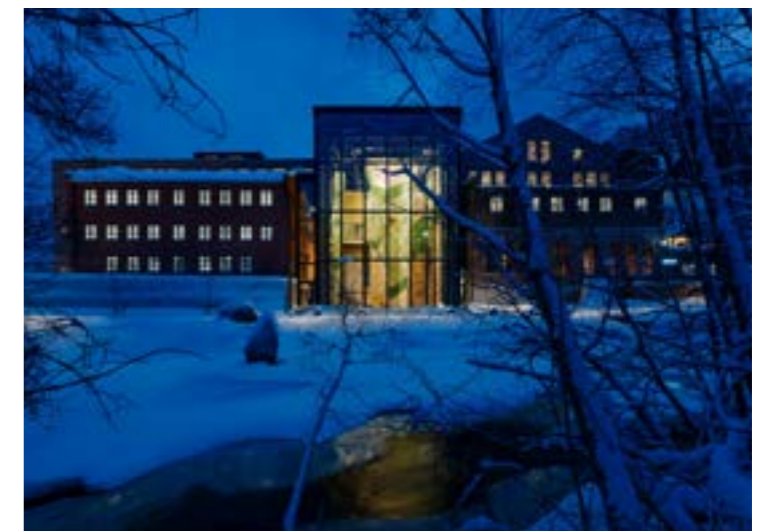
Ferdigstilling av Vollsveien 13H / Fåd 38
